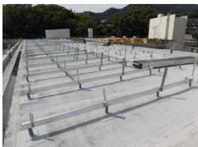
【8月24日現在の屋上の様子】
