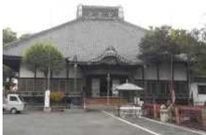
[現在の浄運寺 明治6年仮校舎]
