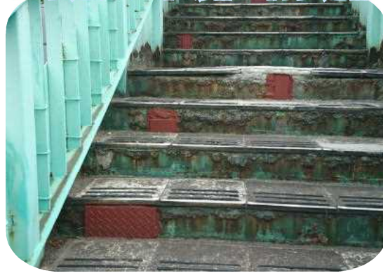
階段に空いていた穴が鉄板で補修されました。
