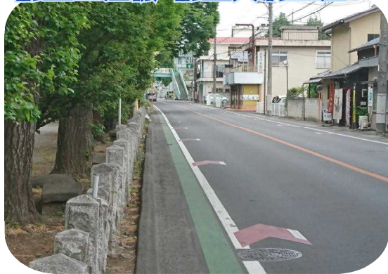
外側線が引き直され、自転車走行帯も明記されました。
