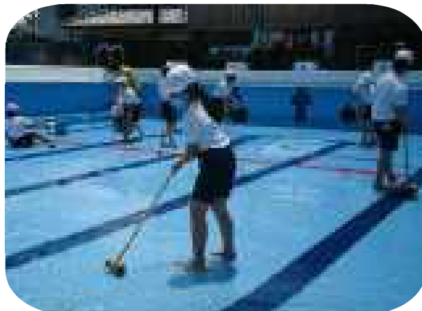
6年生は滑るプールの床面を総仕上げ
